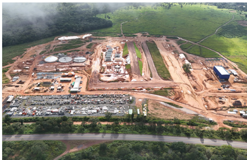
A nova unidade de recepção de grãos da Castrolanda está sendo construída em Colinas do Tocantins (TO), numa área de 83 hectares, às margens da BR-153 e terá capacidade inicial 44 mil toneladas de armazenagem
