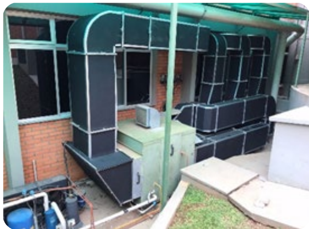
a. Reforma completa do sistema da estufa, utilizada para análise de matéria seca.
